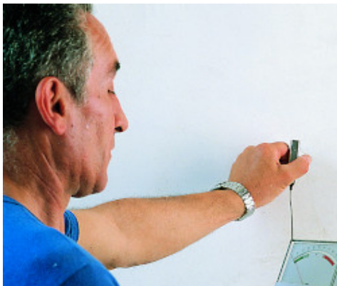
Feuchtemessung des Putzuntergrundes
