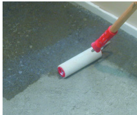
Auftragen von Primer G mit der Rolle
