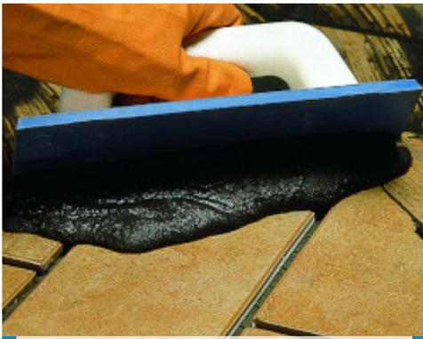
Verfugung von Spaltplatten mit **Keracolor GG + Fugolastic** im Außenbereich
