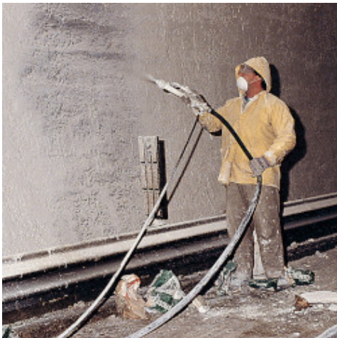
Verarbeitung von Planiseal 88, weiß im Spritzverfahren in einem Autobahntunnel
