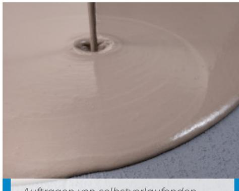
Auftragen von selbstverlaufenden Spachtelmassen auf trockener Eco Prim Grip Plus auf einem Altuntergrund
