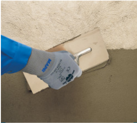
Verarbeitung im Spachtelverfahren
