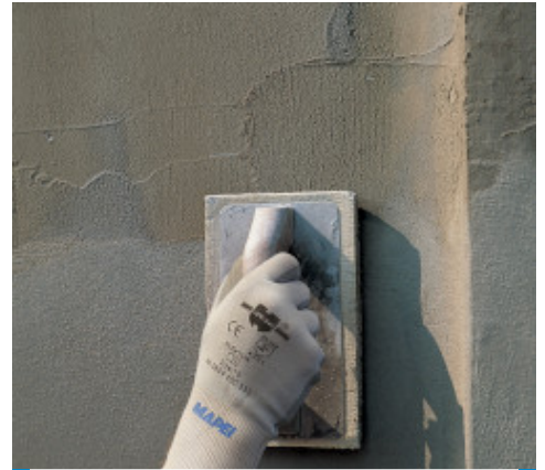
Glätten mittels Glättkelle
