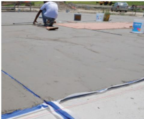
Abdichten eines Estrichs mit **Mapelastic Zero** und **Mapeband**
