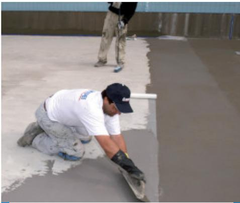
Abdichtungsarbeiten an einem Schwimmbecken mit **Mapelastic Zero**
