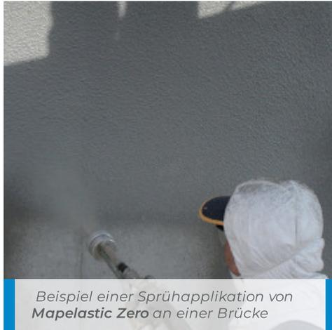
Beispiel einer Sprühapplikation von **Mapelastic Zero** an einer Brücke
