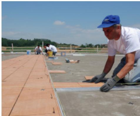
Verlegung keramischer Fliesen mit **Kerabond + Isolastic**
