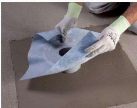
Einbau eines Ablaufs in einer Abdichtungsschicht aus **Mapelastic Zero**
