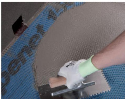
Auftrag von **Mapelastic Zero** auf **Mapenet 150**
