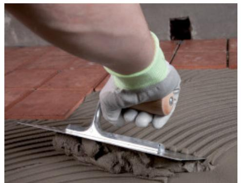
Auftrag von **Granirapid** auf einer mit **Mapelastic Zero** abgedichteten Terrasse
