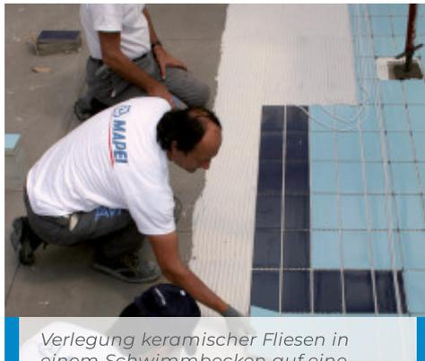
Verlegung keramischer Fliesen in einem Schwimmbecken auf eine Abdichtungsschicht aus **Mapelastic Zero**
