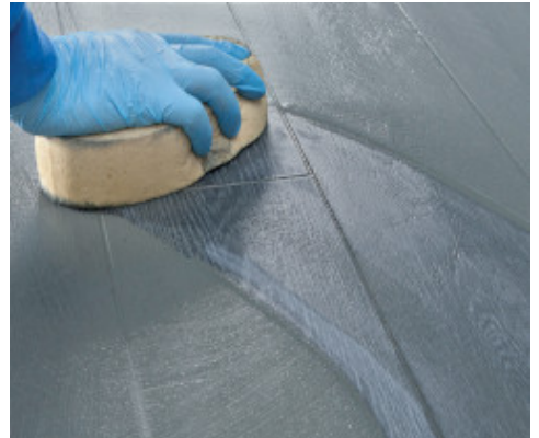
Endreinigung des Fugenmörtels mit einem Schwamm
