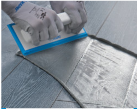
Verfugung eines Bodenbelags mit Holzoptik mit Ultracolor Plus mittels Gummifugbrett
