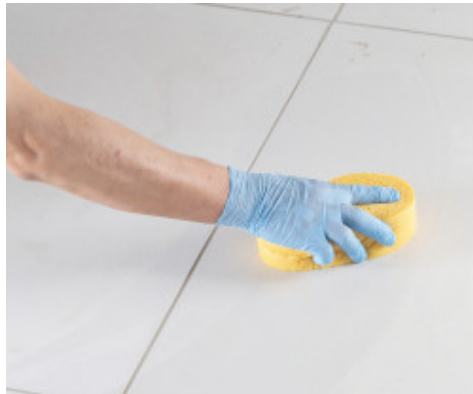
Endreinigung des Fugenmörtels mit einem Schwamm
