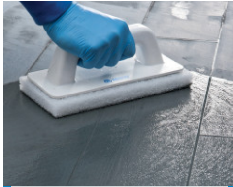
Waschen des angezogenen Fugenmörtels mit einem Schwamm Brett (z.B. Scotch-Brite)
