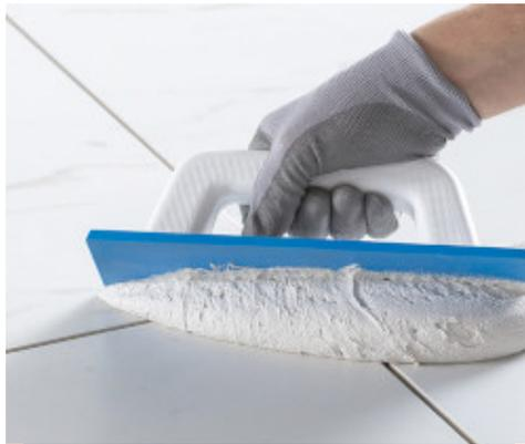
Kerapoxy Easy Design mit Mapei-Gummifugscheibe auftragen
