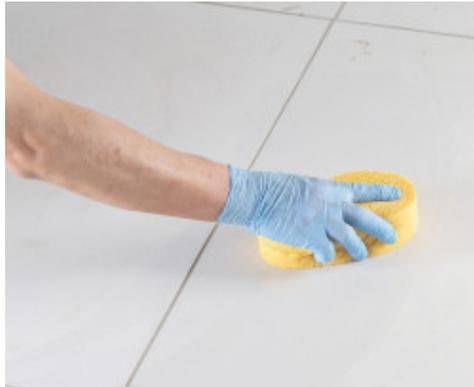
Nettoyage et finition des joints à l'éponge, en mur
