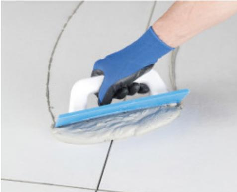
Jointoiement en mur avec la spatule caoutchouc
