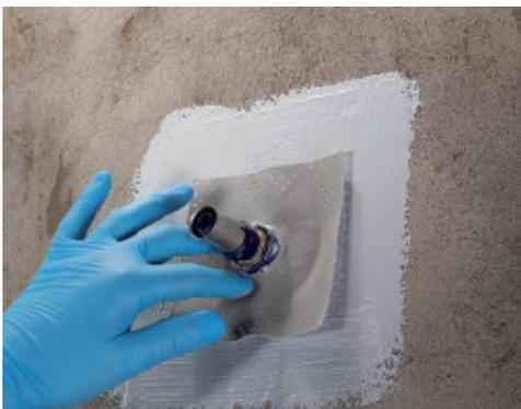
Application d'un joint Mapeband PE 120 pour les conduits traversants avec Mapegum WPS
