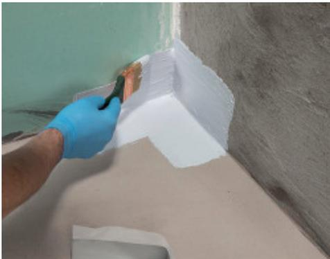
Application d'une pièce d'angle 90° de Mapeband PE 120 avec Mapegum WPS
