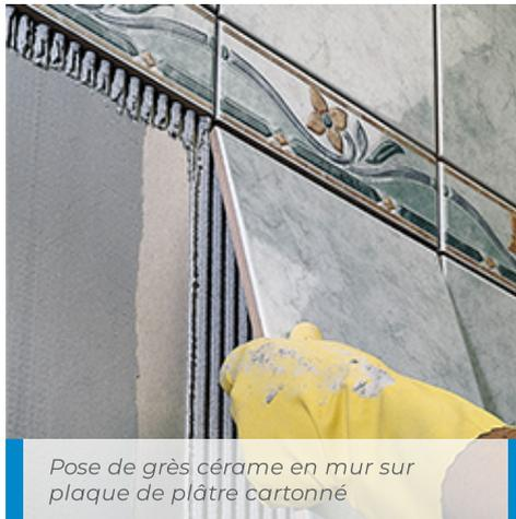
Pose de grès cérame en mur sur plaque de plâtre cartonné
