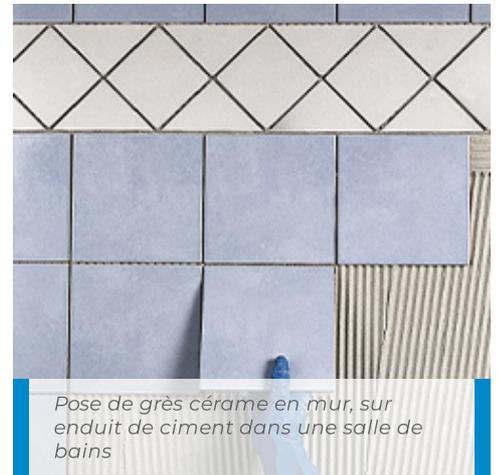
Pose de grès cérame en mur, sur enduit de ciment dans une salle de bains
